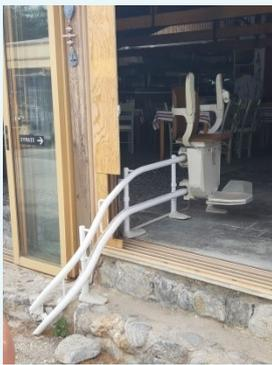
Systeem waarbij je met stoeltje en al het water inglijdt. Aangedreven door zonne-energie.
